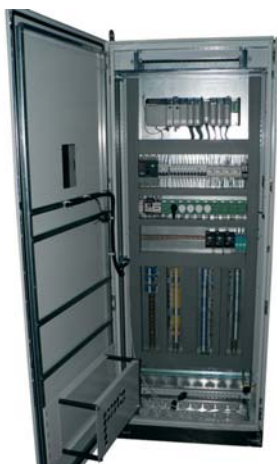
Шкаф управления главной вентиляционной установкой АК «АЛРОСА»
