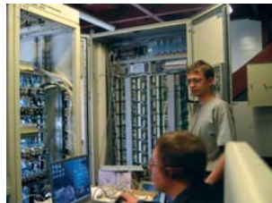
Пуско-наладочные работы на драге №202 АК «АЛРОСА»
