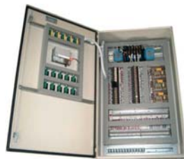
Шкаф управления производства спутников платины «Красцветмет»
