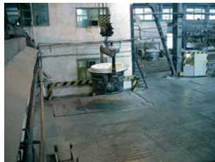
Система автоматического взвешивания и идентификации ковшей с жидким металлом Братский алюминиевый завод
